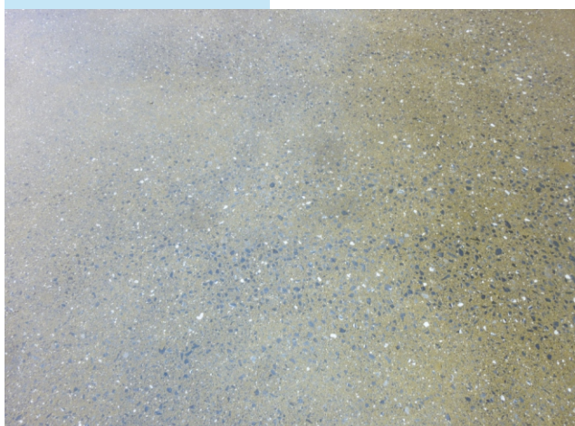
Particolare del nuovo pavimento
