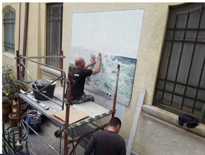
La posa del pannello ceramico
